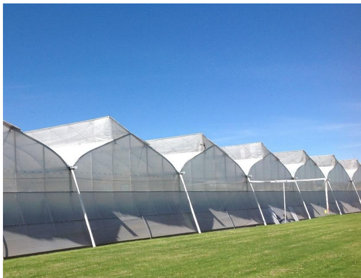
ABERTURA EN EL TECHO
