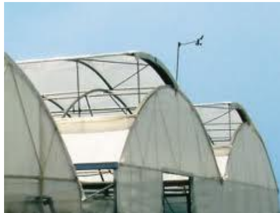
B. Apertura de techo donde colocar IMPOLLIRETE.
